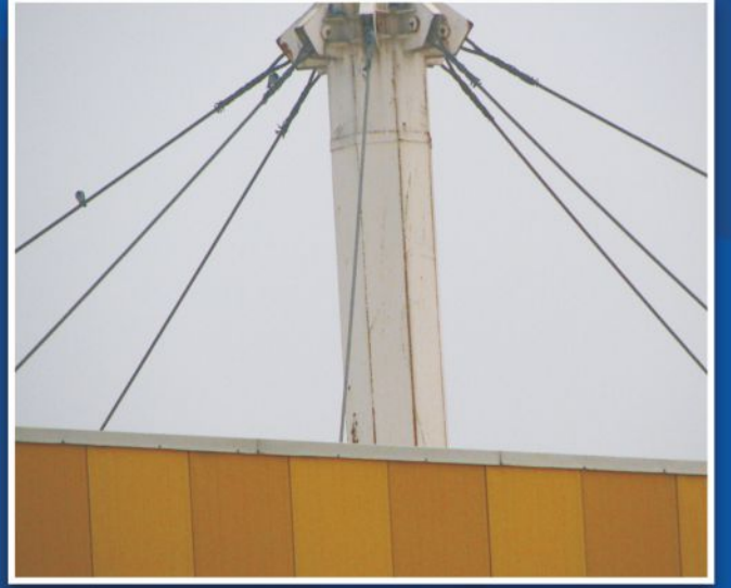
KONYA TÜYAP FUAR ALANININ 45 mm. ÖRGÜLÜ ÇELİK HALAT SAPAN SİSTEMLERİ
